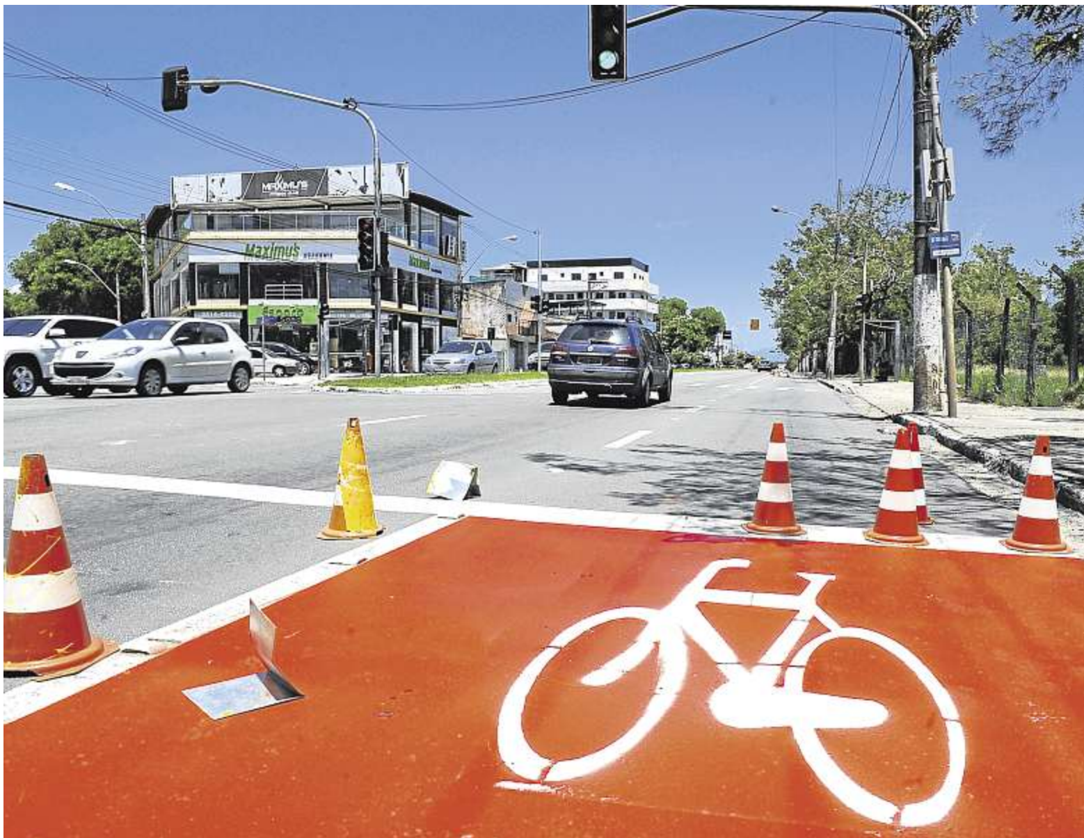
A Avenida Adalberto Simão Nader já está recebendo pintura e sinalização; trabalho será concluído no início da próxima semana
