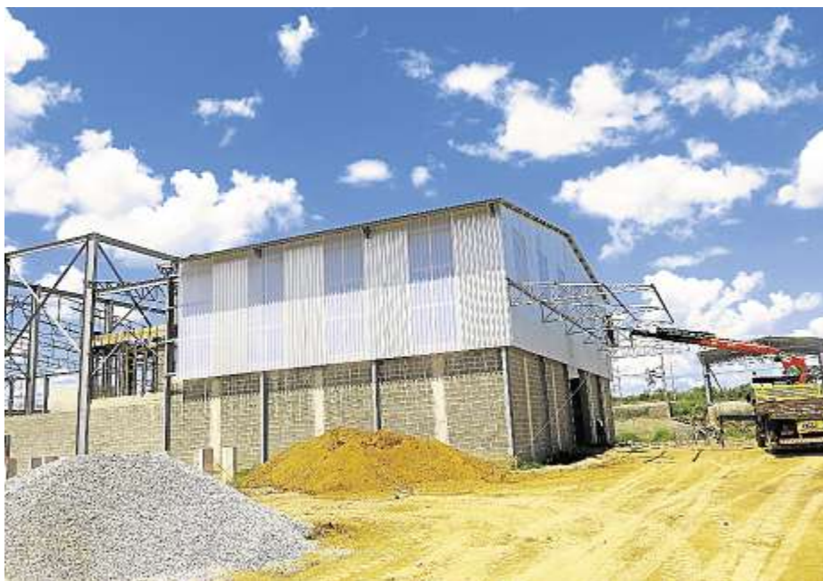
Obras da nova fábrica de ração, cuja localização é estratégica para distribuição
