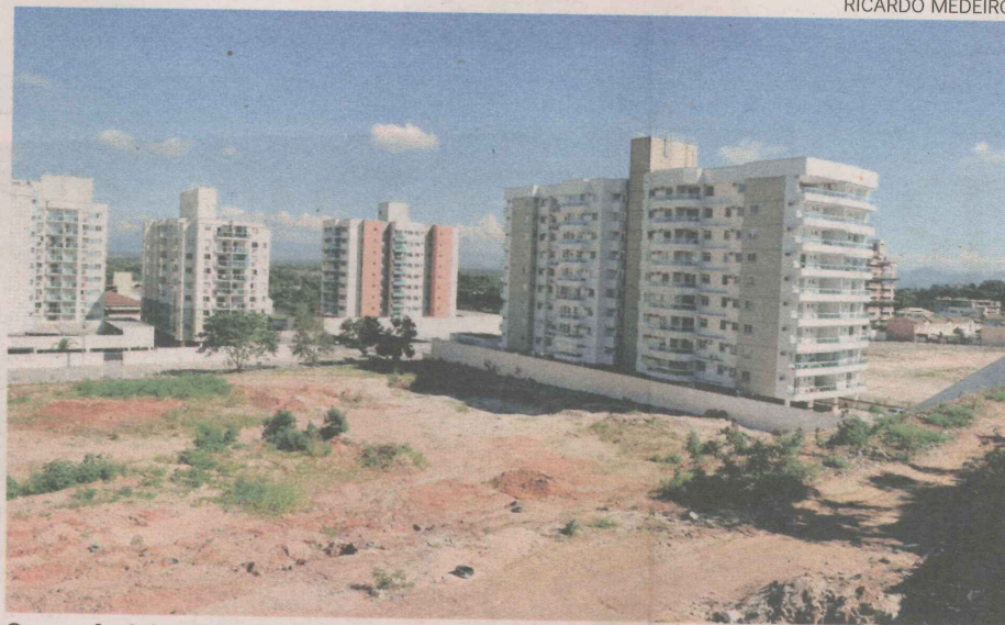
Cerca de 1,6 mil imóveis no loteamento Santa Terezinha estão em risco
