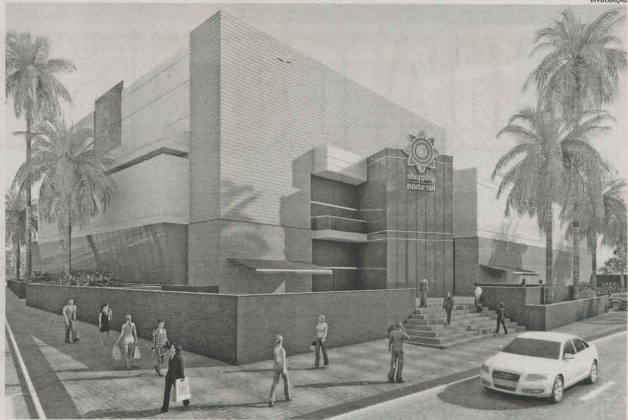
O SHOPPING NORTE SUL, em Jardim Camburi, está passando por uma reformulação na área externa
