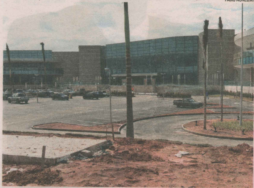
OBRAS do Boulevard Vila Velha: shopping terá espaço fitness e esportivo
