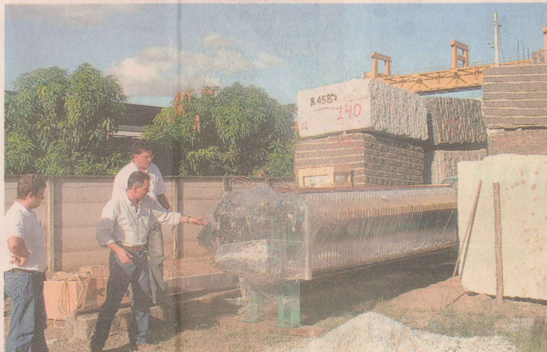
PLANO. Chineses querem instalar uma fábrica de corte e polimento de chapas. FOTO: SAMUEL SABINO
