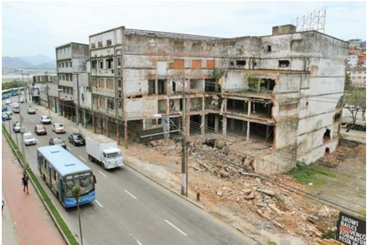
PRÉDIOS estão sendo demolidos para a ampliação da avenida Elias Miguel, que passará de três para seis faixas
