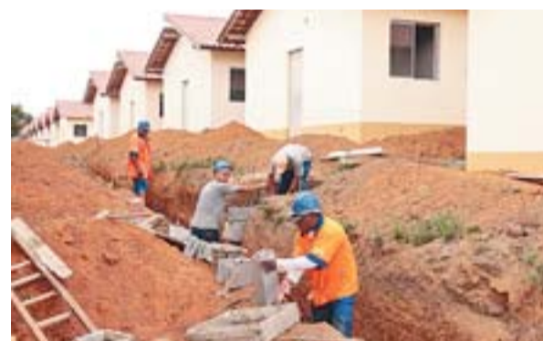
NOVO HORIZONTE: obras das 324 casas estão em fase de conclusão
