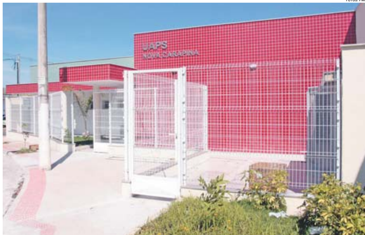
A UNIDADE DE SAÚDE DE NOVA CARAPINA II está entre as obras que foram reiniciadas pela atual administração
