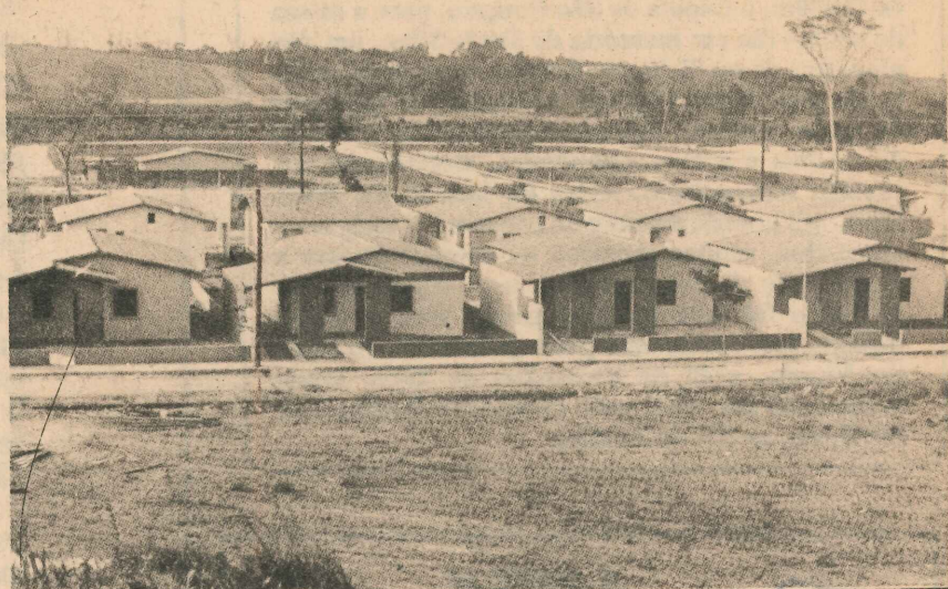
Na área já foram construídas diversas casas residenciais
