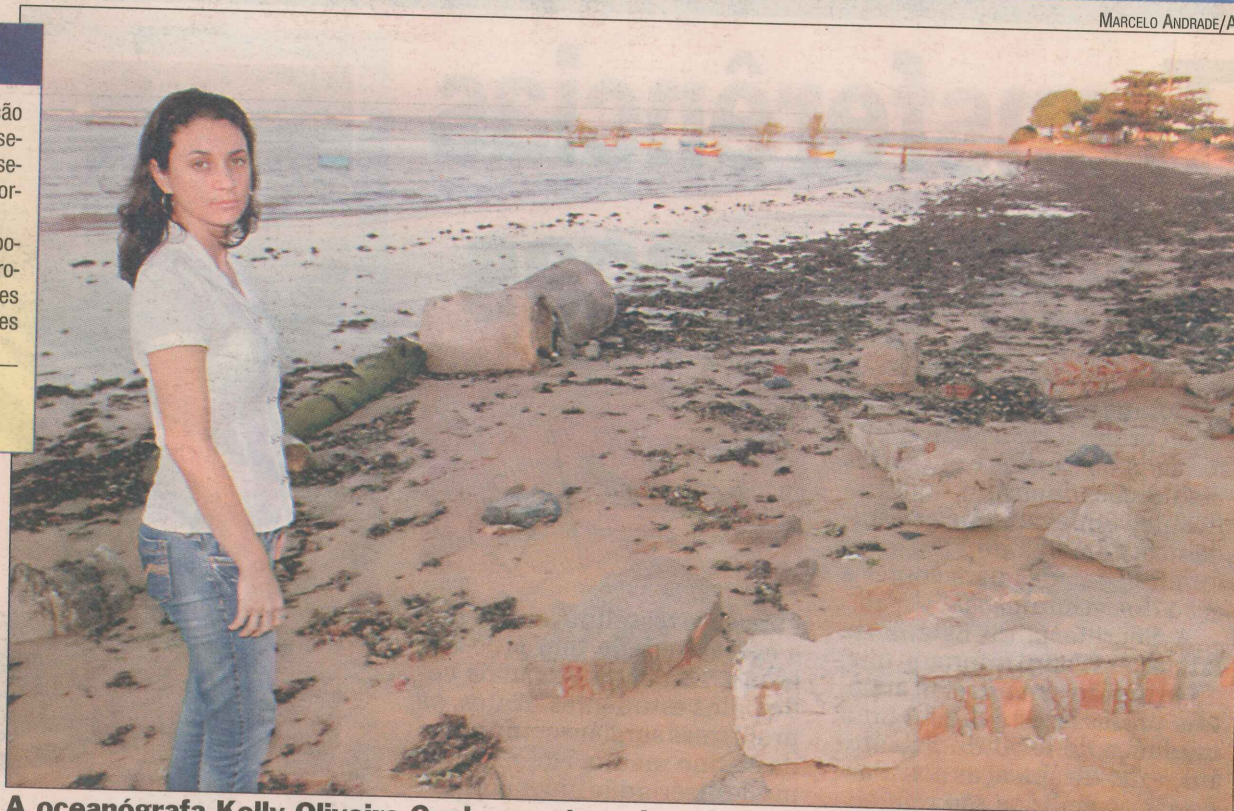
A oceanógrafa Kelly Oliveira Cunha mostra o local onde a erosão já destruiu até muros
