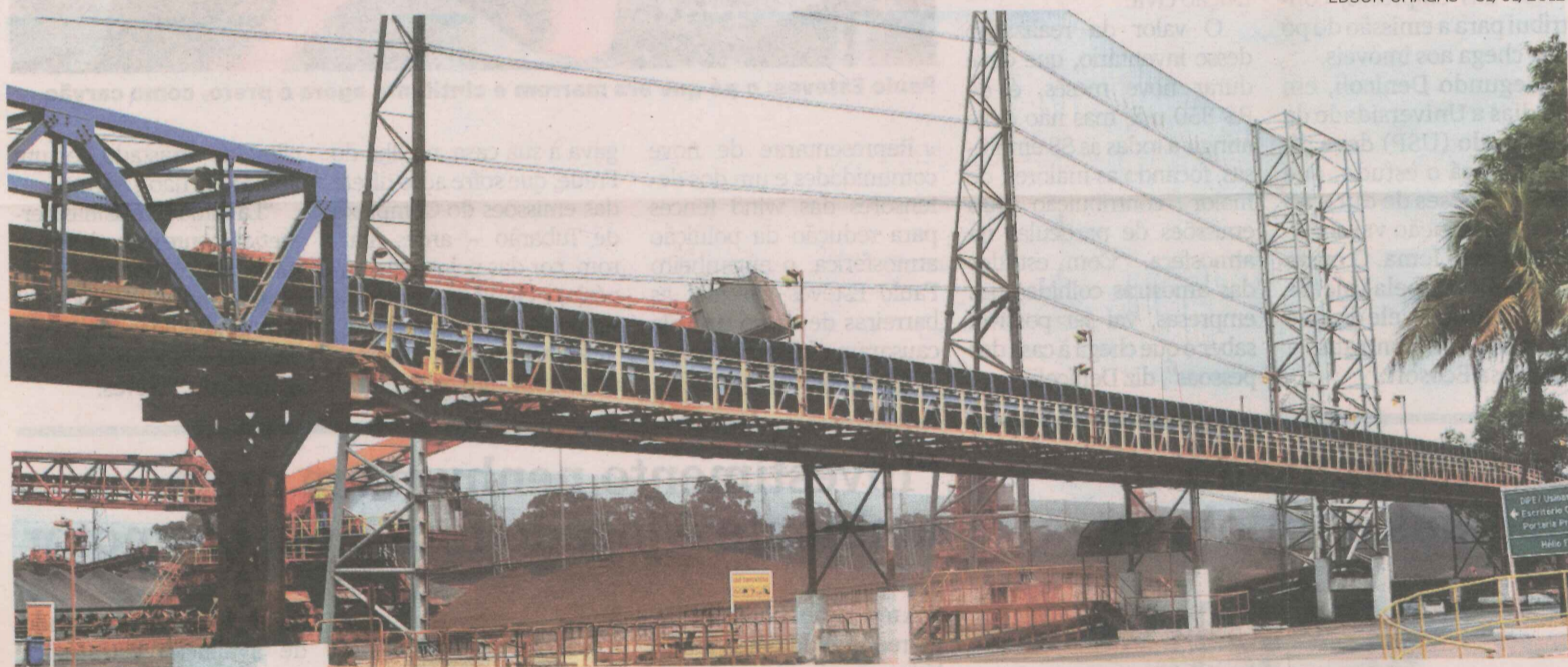
Empresa instalou cinco wind fences em Tubarão; nelas e em outras medidas de controle ambiental, foi investido meio milhão de reais
