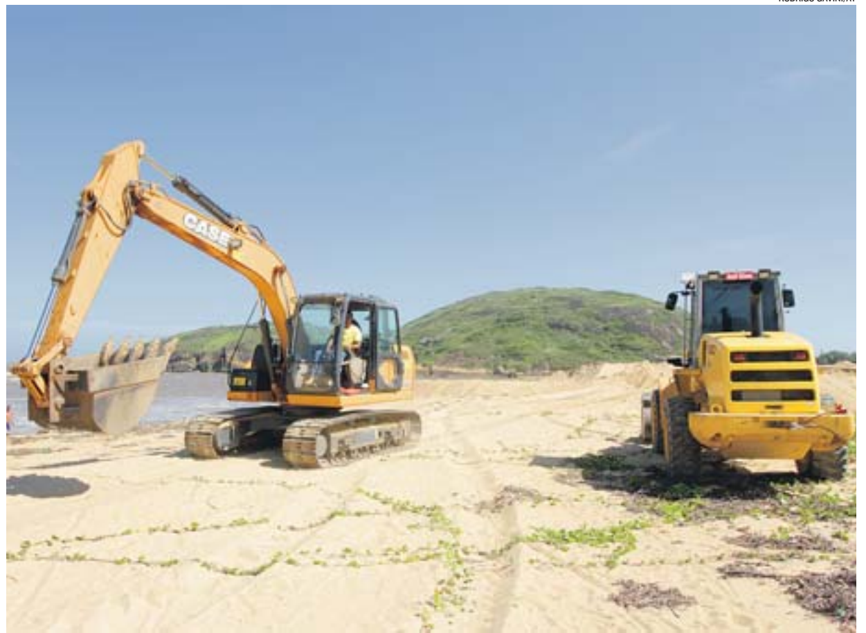
MÁQUINAS foram utilizadas para abrir um canal na foz do Rio Jucu, que foi coberto porque a água não escoou
