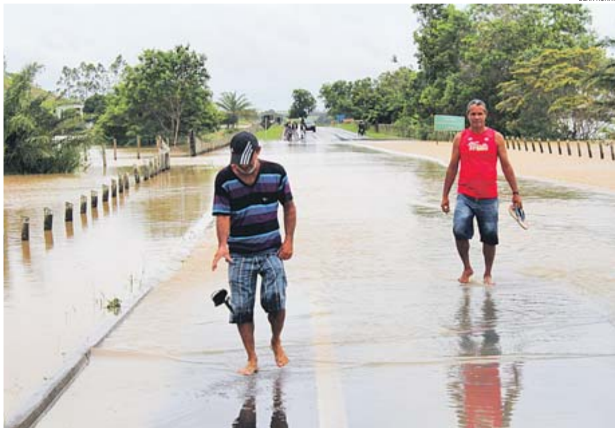
BR-101, EM SÃO MATEUS: rio Cricaré está cinco metros acima do nível normal, de acordo com a Defesa Civil
