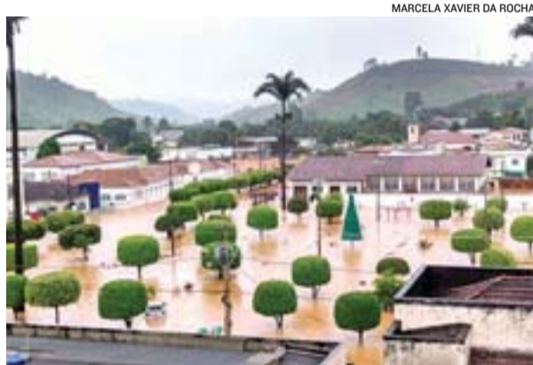
PRAÇA completamente alagada no centro de Itaguaçu
