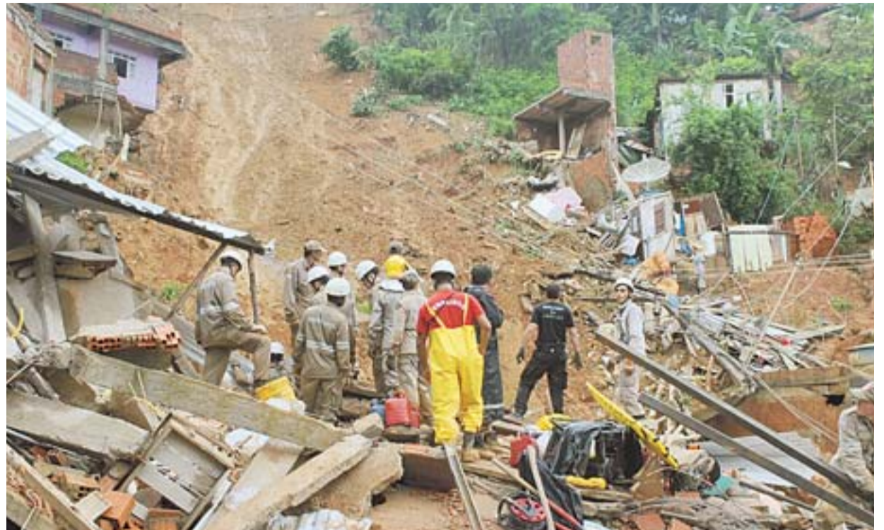
UM MURO DE CONTENÇÃO desmoronou e arrastou cinco casas em São Marcos, Colatina. Uma pessoa morreu
