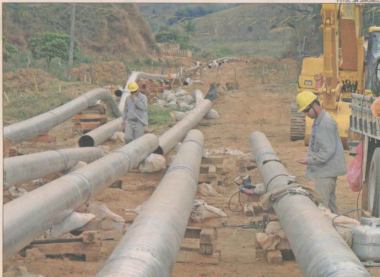
Obras de expansão do mineroduto da Samarco, em Guaçuí: município conectado ao mundo
