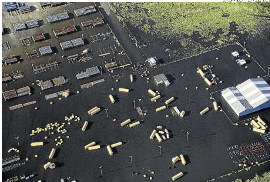
Indústrias no Tims, às margens da Rodovia do Contorno, Serra, ficaram alagadas
