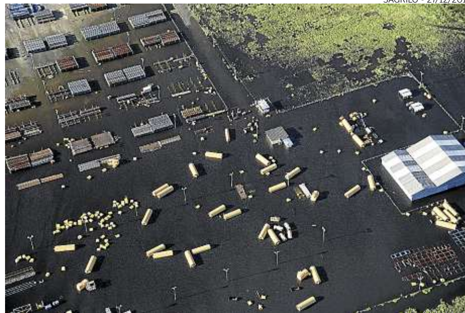
Indústrias no Tims, às margens da Rodovia do Contorno, Serra, ficaram alagadas
