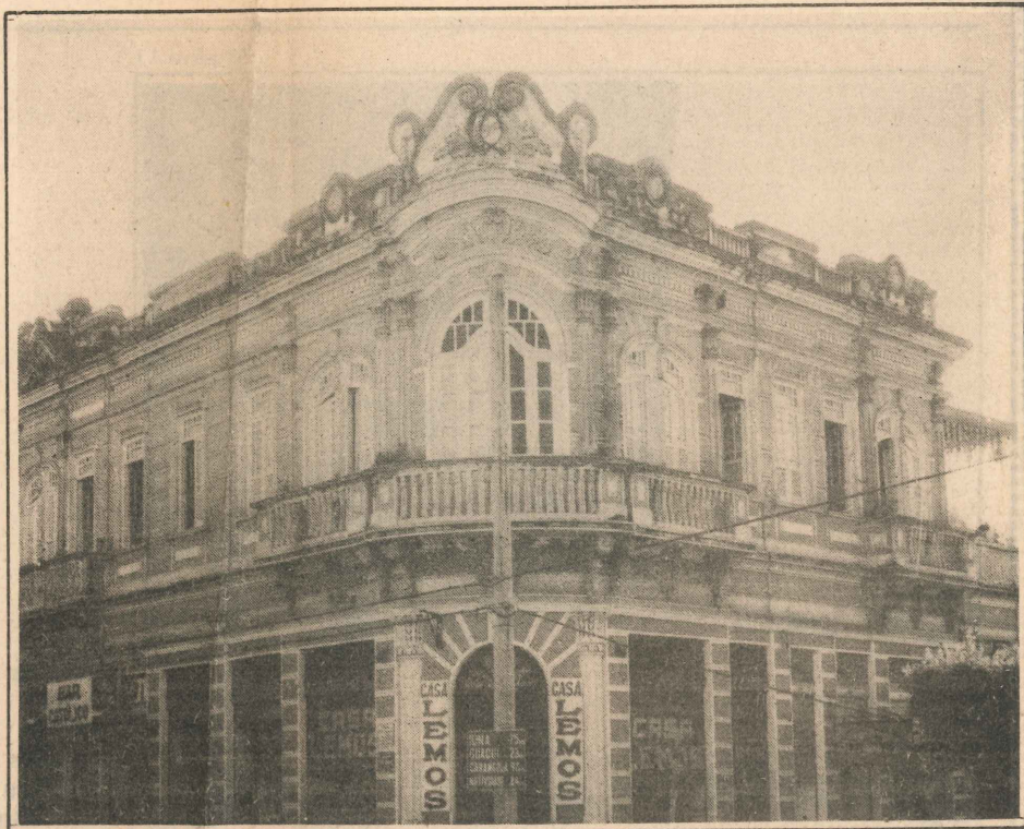
Um dos patrimônios de Alegre: no centro da cidade, um prédio antigo
