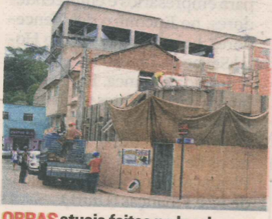
OBRAS atuais feitas no local
