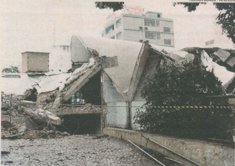
O PRÉDIO do Iate Clube de Colatina foi parcialmente demolido esta semana
