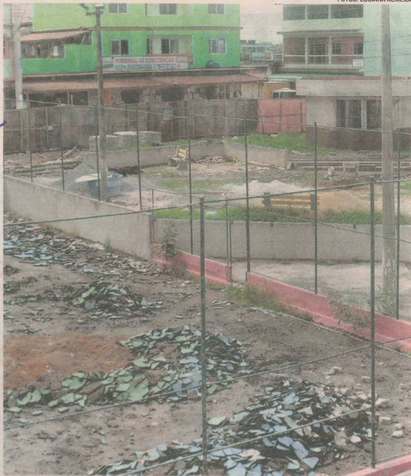
PRAÇA GILSON MENDONÇA: moradores reclamam do atraso nas obras
