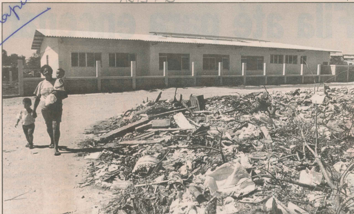
No bairro, podem ser encontrados terrenos invadidos por entulhos e detritos
