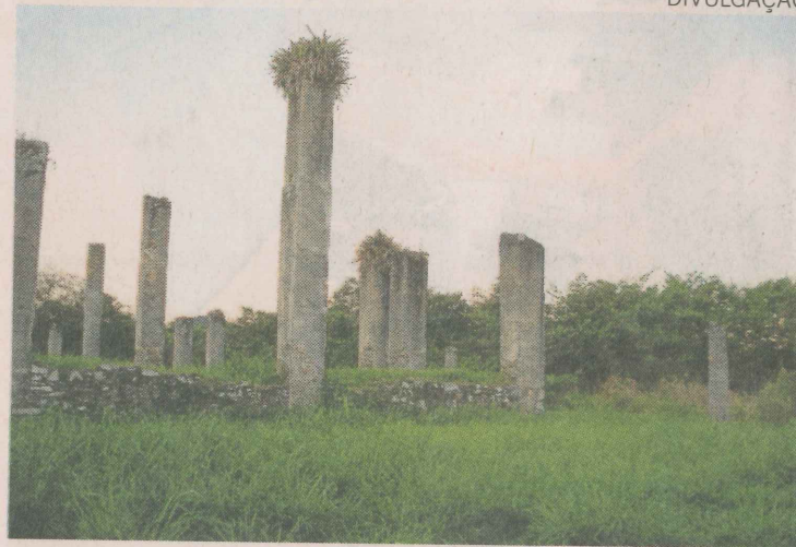
MATERIAL. Colunas foram feitas com cal, areia e conchas
