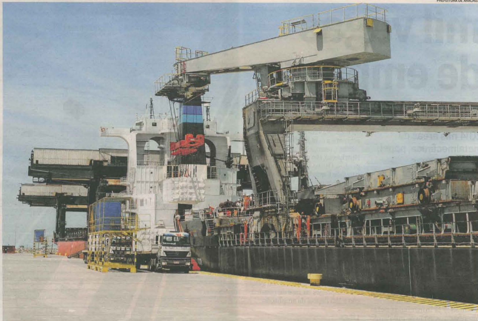
O PORTOCEL deve receber investimentos de R$ 490 milhões para modernização e ampliação da capacidade operacional do terminal
