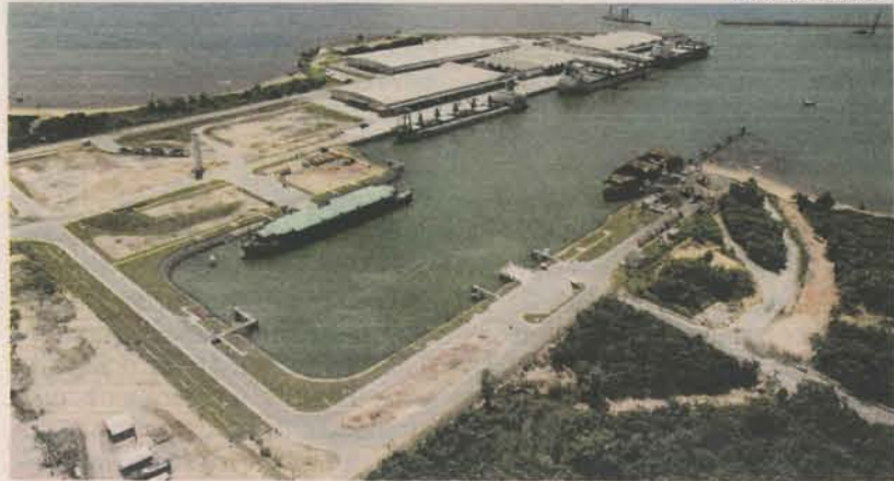
OBRA DO PORTOCEL: 500 empregos na construção e 150 após ampliação
