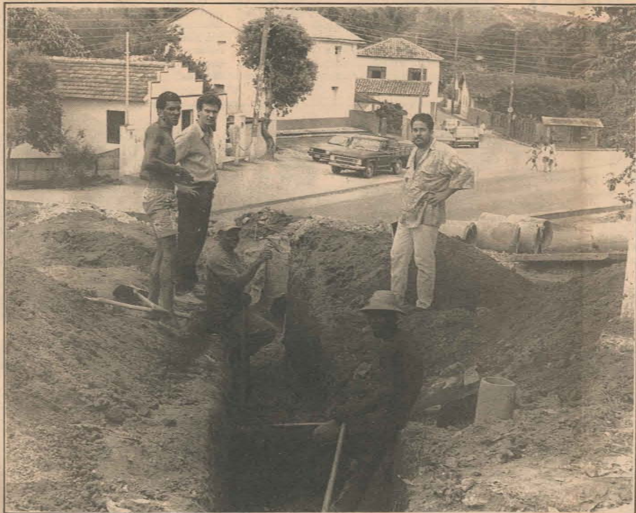
Implantação de esgotos no distrito de Baunilha
