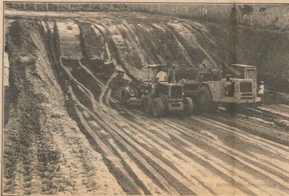
Todo o lixo recolhido será agora depositado no aterro sanitário
