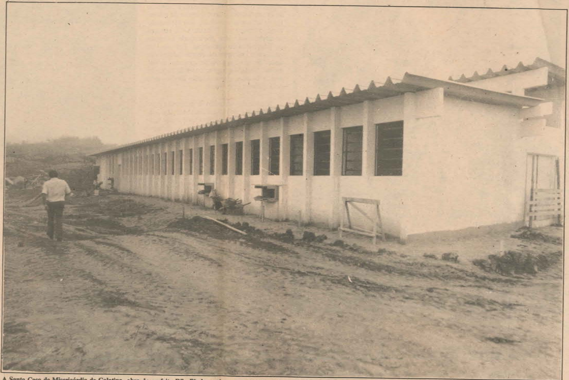
A Santa Casa de Misericórdia de Colatina, obra do prefeito Dilo Binda, está entre os objetivos da atual administração, de priorizar a saúde no município
