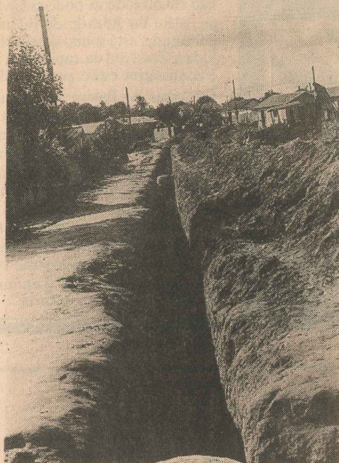
A rede de esgoto vai beneficiar ainda os conjuntos Vila Fernandes e Vila Tavares
