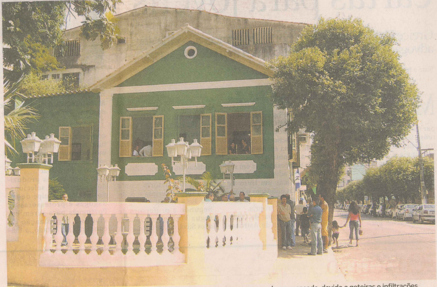
REFORMA. O prédio onde morou a família Braga chegou a ser interditado no começo do ano passado, devido a goteiras e infiltrações. Ontem, o local foi reaberto ao público e voltou a abrigar a biblioteca municipal
