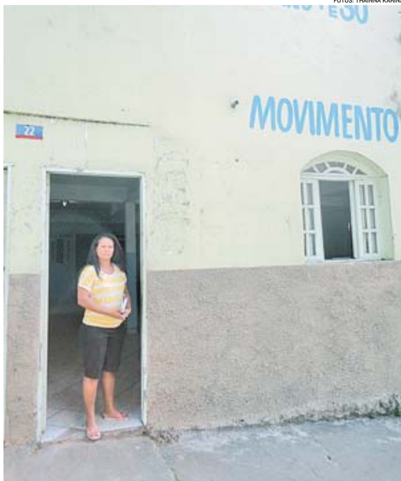
MARIA APARECIDA disse que local está sendo reformado para as aulas
