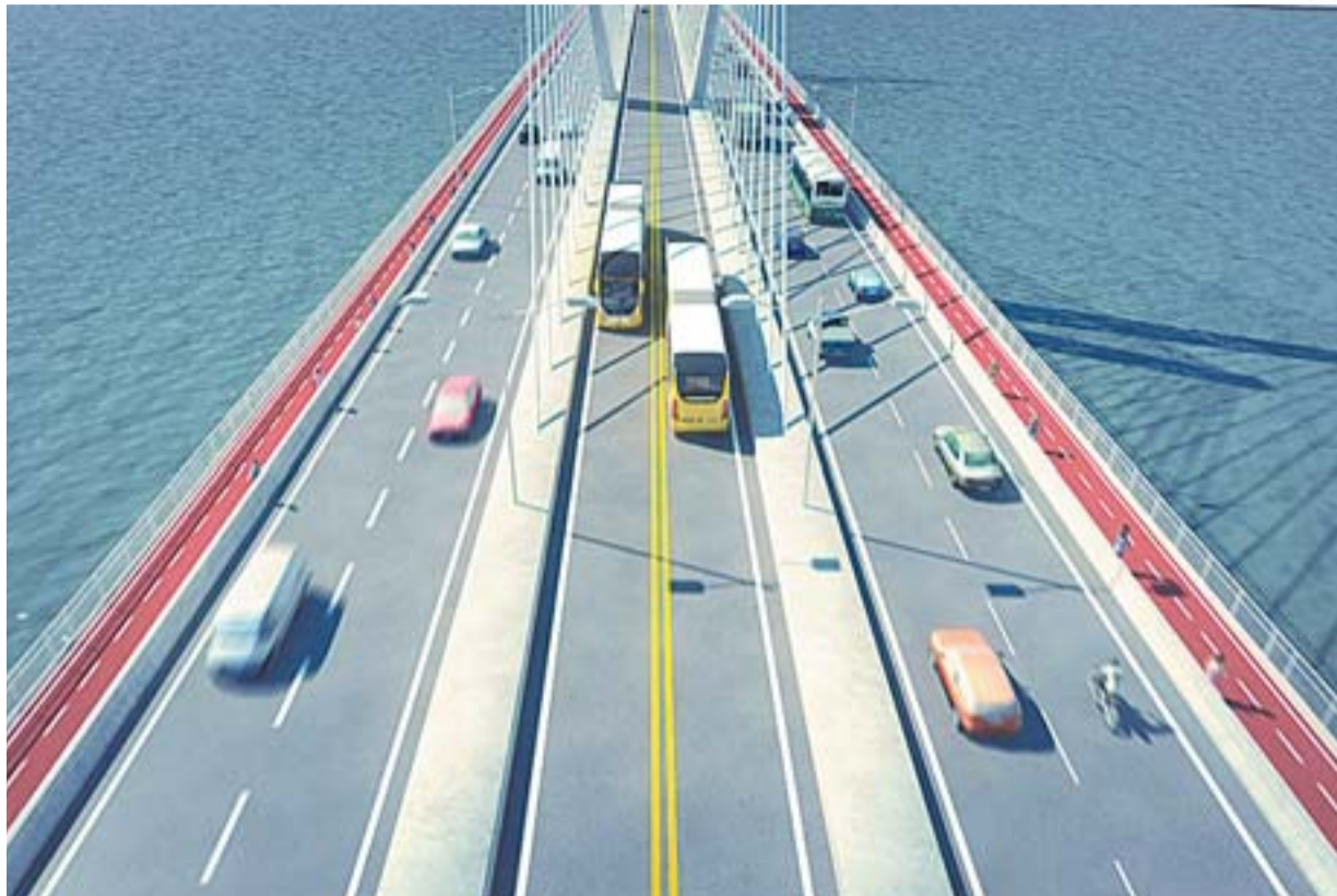
PROJEÇÃO mostra como vai ficar a Quarta Ponte depois de pronta. Serão duas faixas exclusivas para ônibus
