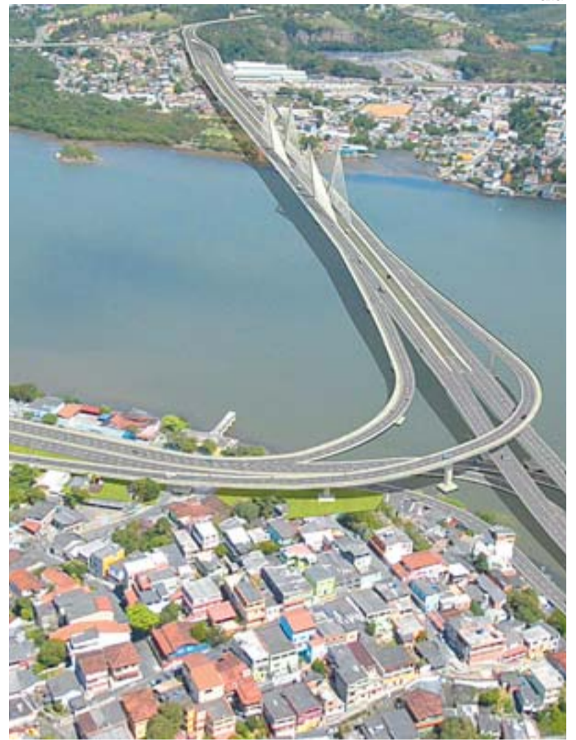
PROJETO da 4ª Ponte, que terá 300m de extensão em eixo viário de 7,9 km
