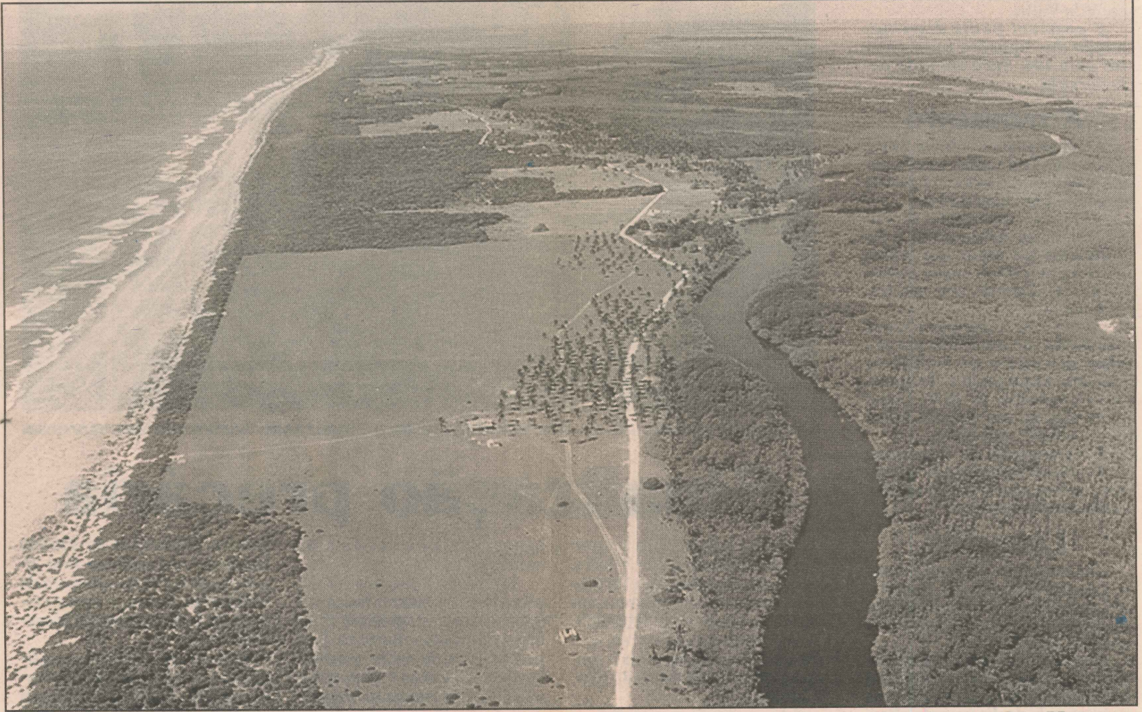
Área onde será construído terminal de embarque da Petrobras, no distrito de Campo Grande, em São Mateus
