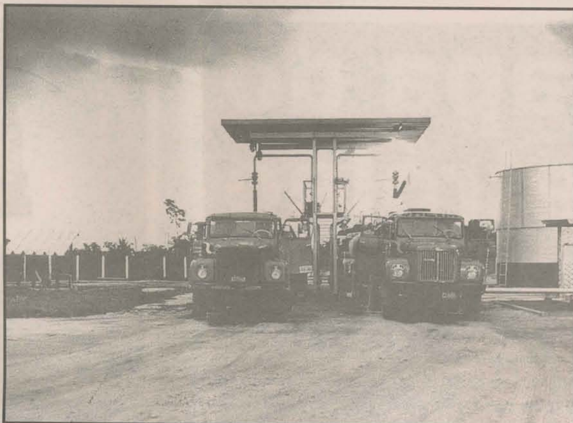
As equipes técnicas passaram três anos realizando testes na área terrestre da bacia capixaba. Em 1959, começaram os trabalhos de perfuração dos primeiros poços
