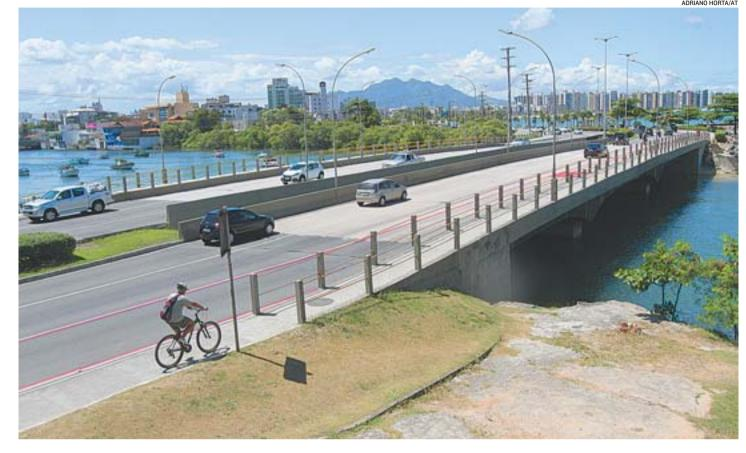
**CAMBURI** terá obra para ampliar o tamanho da calçada, que passará de 1,20m para 3,80m. Ciclovia será feita em estrutura metálica coberta de concreto
