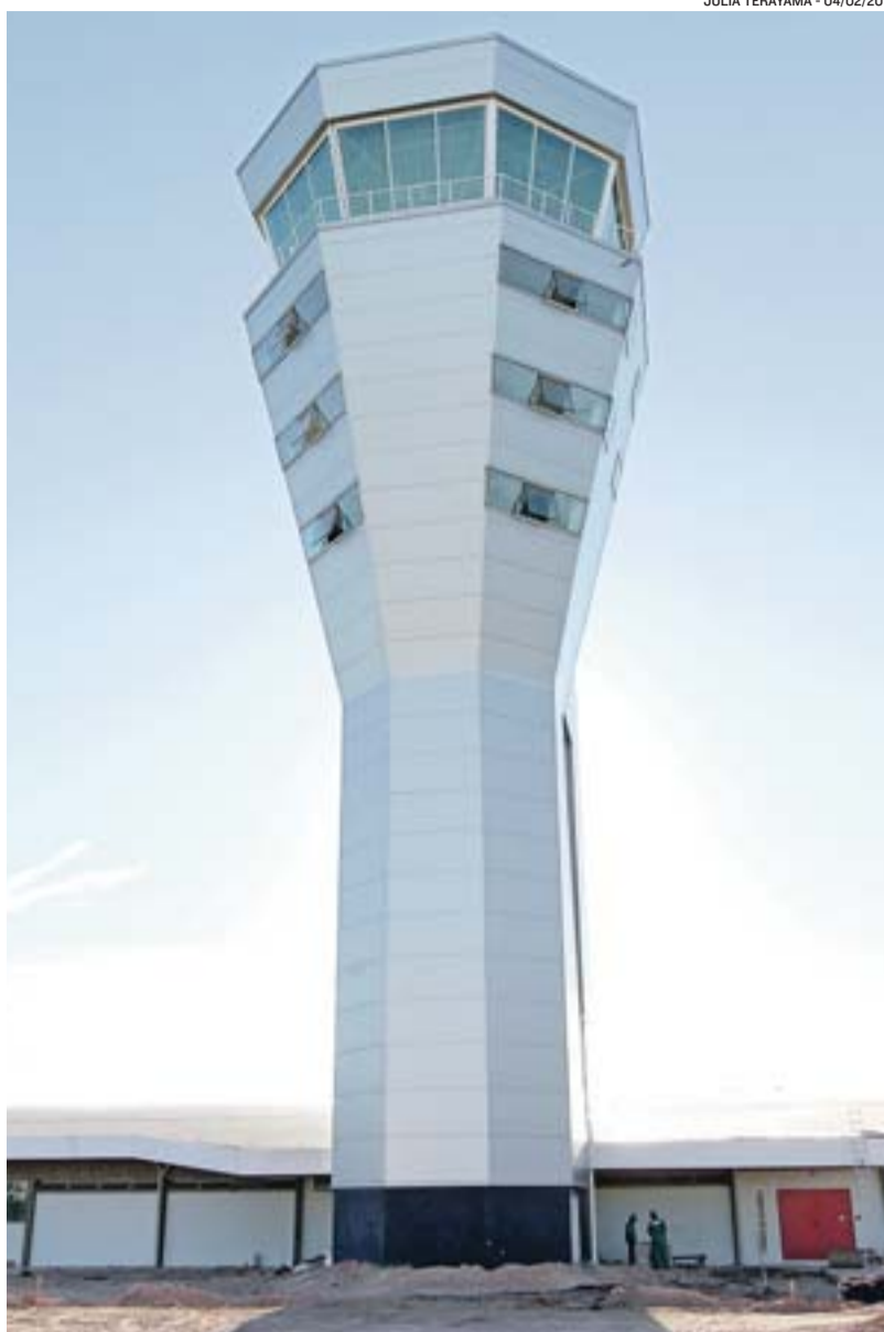
NOVA TORRE DE CONTROLE: inauguração prevista para o dia 25 de março
