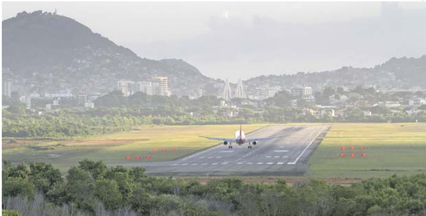
AEROPORTO DE VITÓRIA: profissionais do setor relatam que a inoperância de alguns equipamentos aumenta os riscos de acidentes
