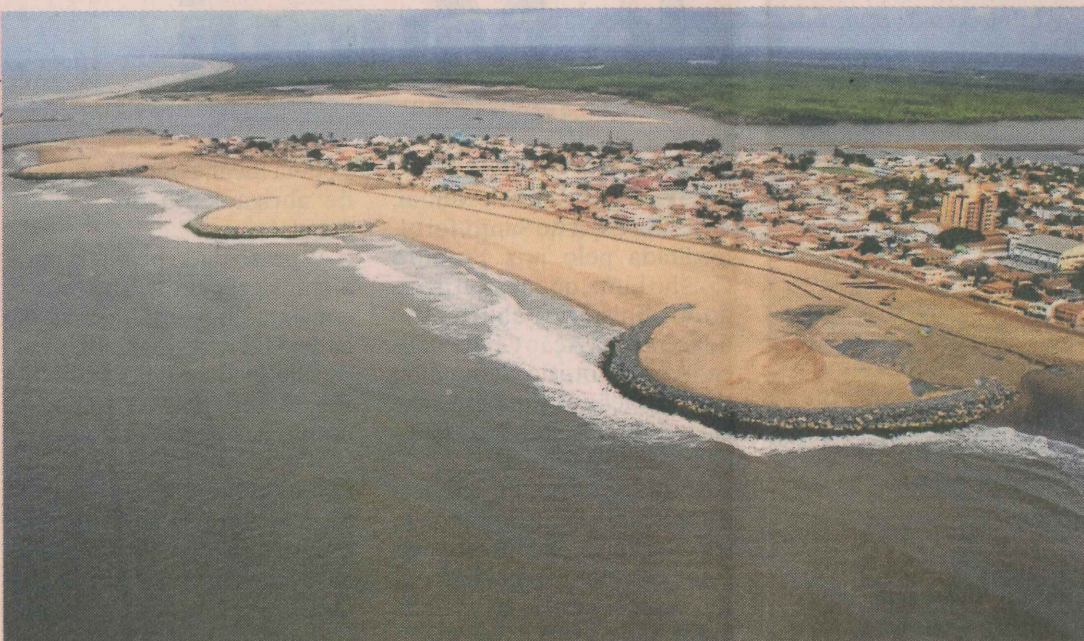
A praia ganhou quebra-mares e será totalmente urbanizada em uma futura etapa de obras
