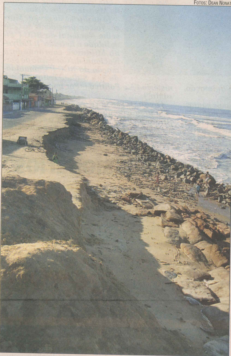
O avanço do mar destrói a orla marítima e o bairro Bugia
