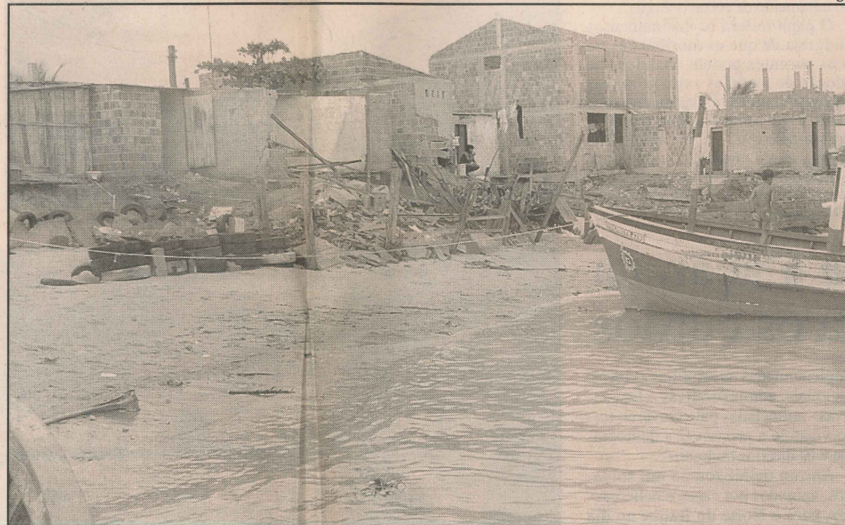
Parte dos 22 mil metros cúbicos de areia já depositados no local afetado pela erosão foi levada pelo mar
