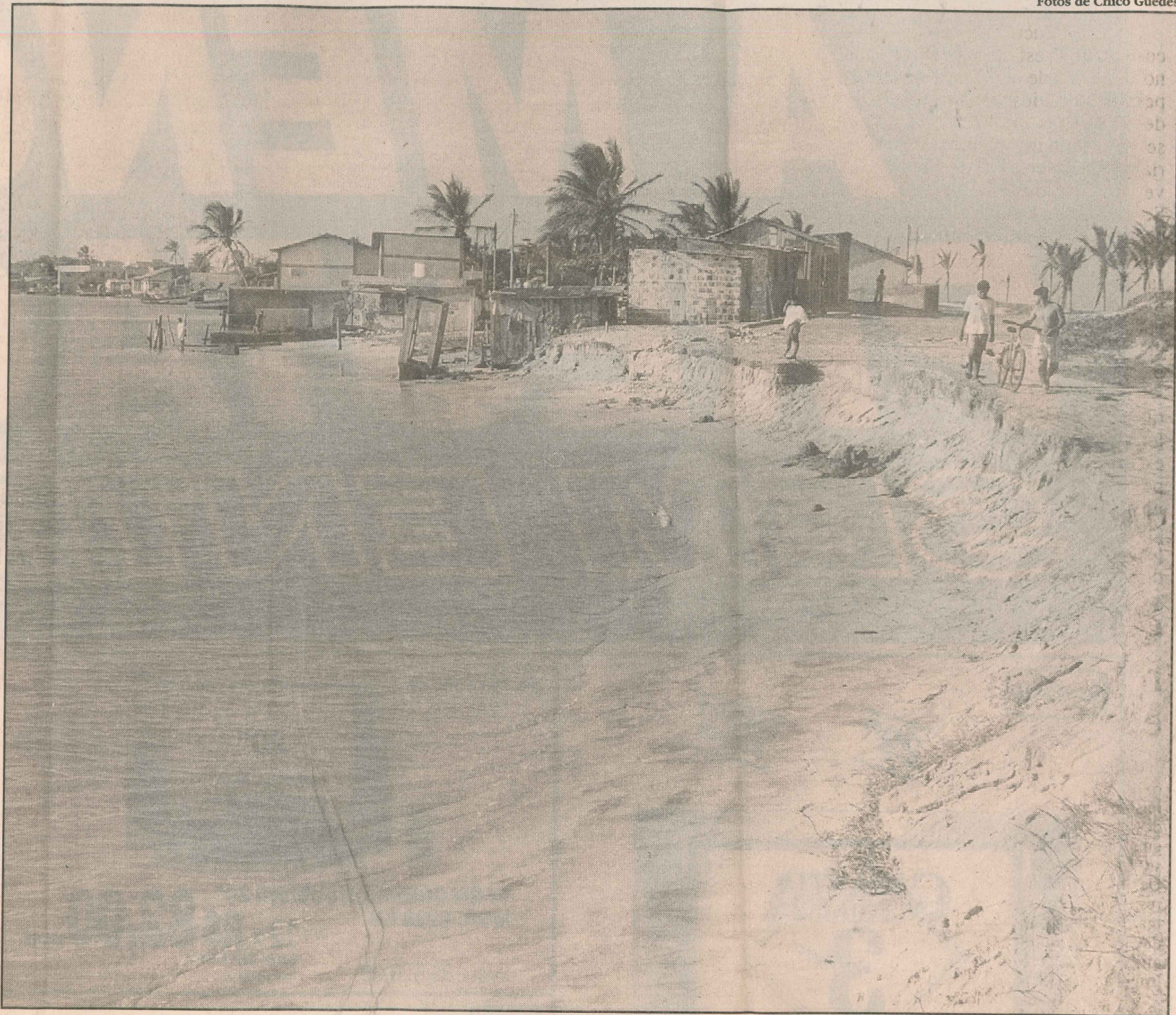
O mar agitado vem destruindo a margem ao norte do rio e deixando os moradores apreensivos, além de constituir uma ameaça a parte da cidade
