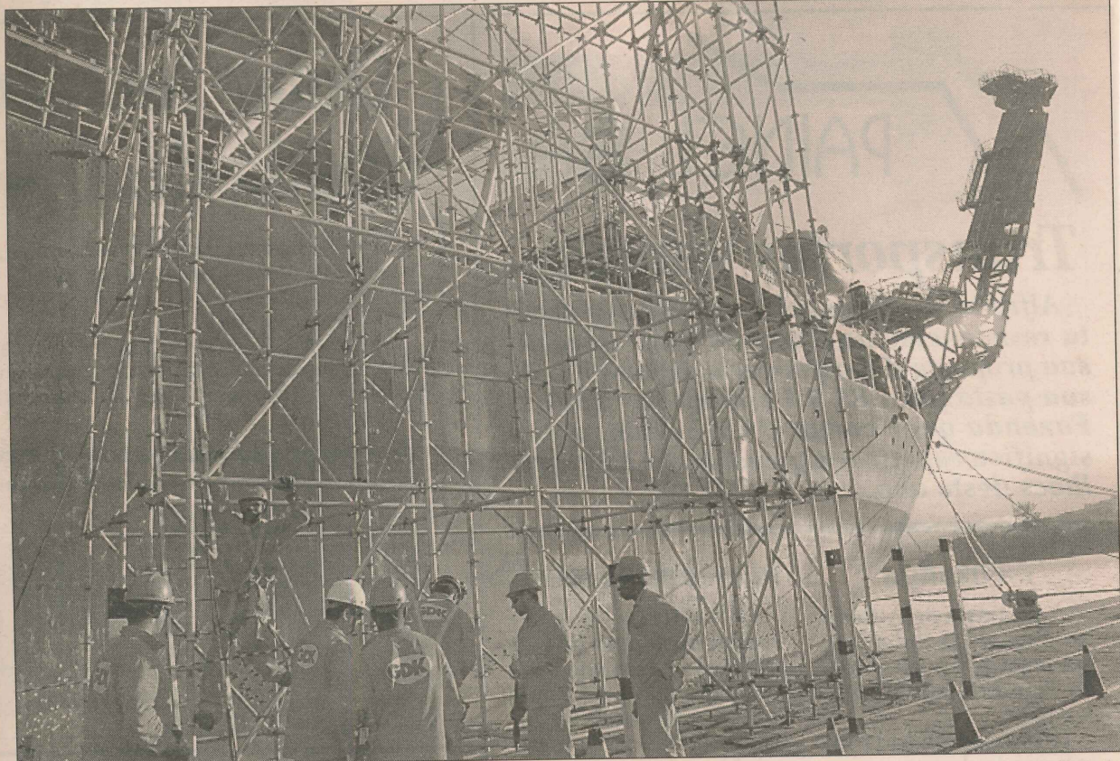
Trabalhadores preparam toda a estrutura para as reformas da plataforma no porto de Vitória
