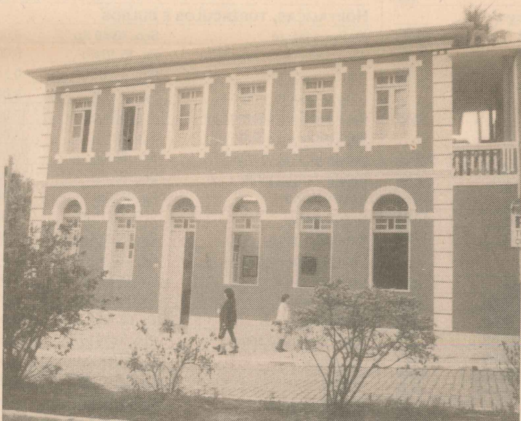
Limpeza e restauração do prédio da Secretaria Municipal de Educação.
