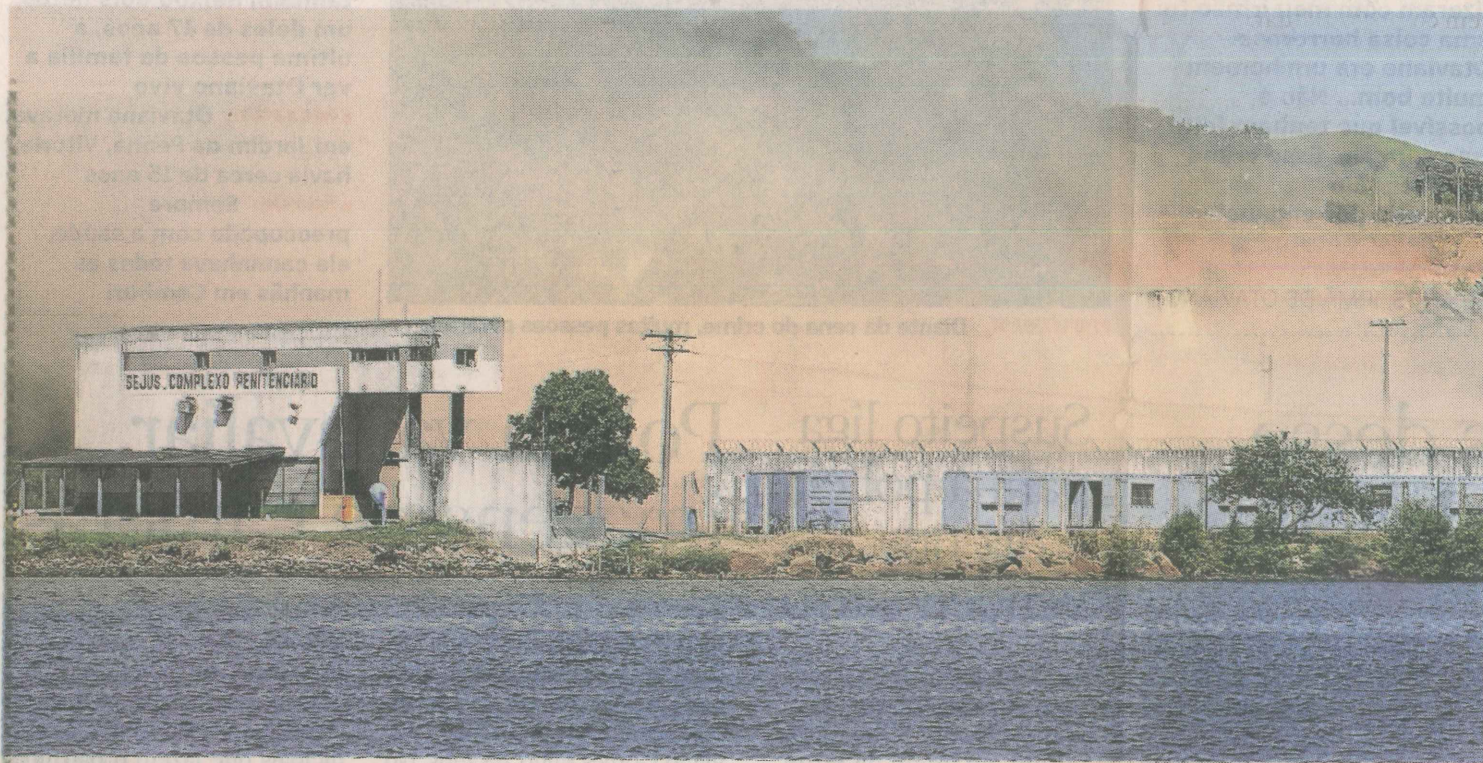
VOEIRA. A demolição do prédio de 1,3 mil metros quadrados da Casa de Passagem demorou menos de três segundos
