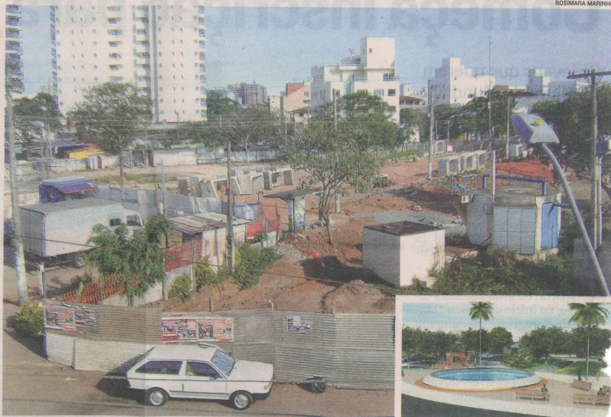
A PRAÇA DA RODOVIÁRIA , em Muquiçaba, está em obras. Projeto mostra como será túnel sob avenida (destaque)
