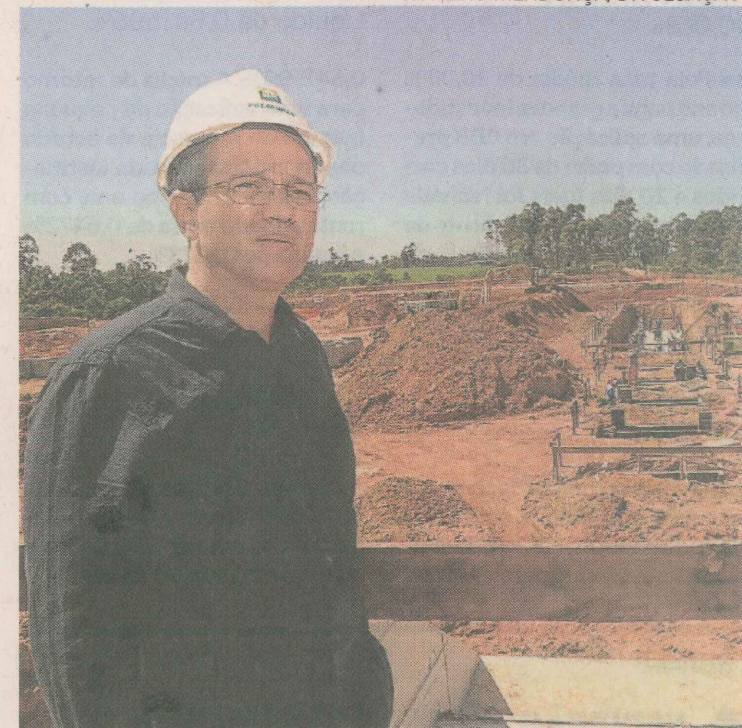
NO CANTEIRO. Paulo Hartung visitou as obras da Petrobras no Sul
