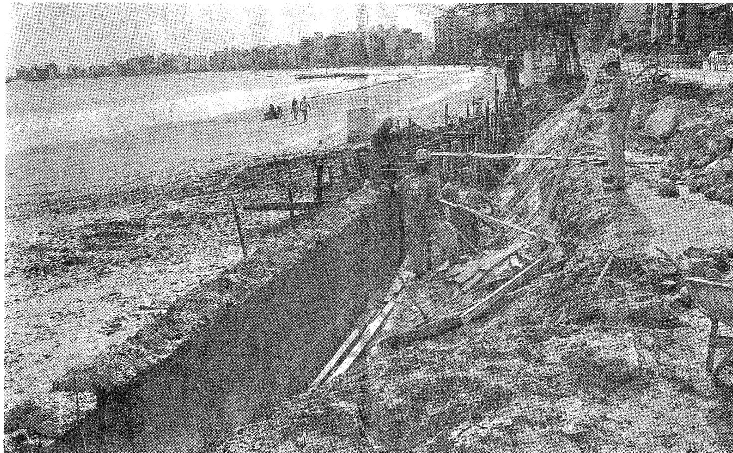
REURBANIZAÇÃO. Quem passa pela Praia do Morro vê canteiros de obras nos lugares onde antes ficavam quase 60 quiosques
