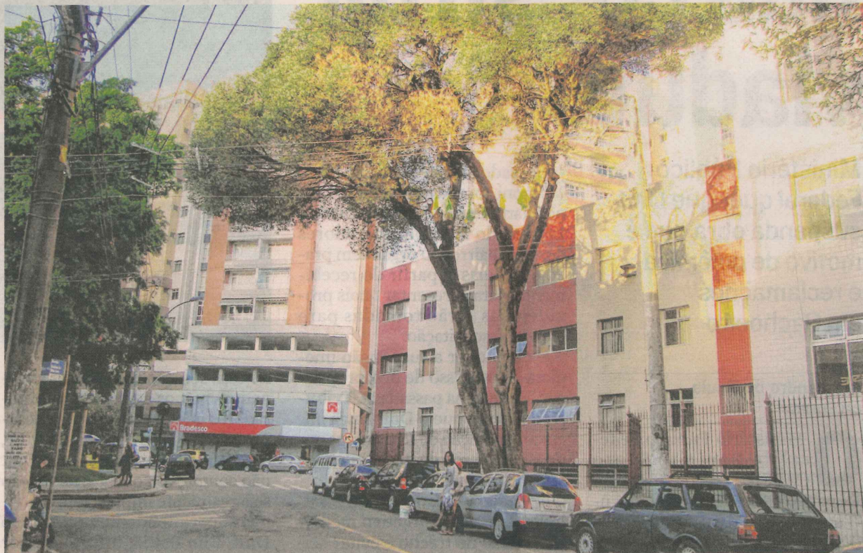
ÁRVORE na avenida Joaquim da Silva Lima, Centro, é reduto de andorinhas, segundo moradores e comerciantes
