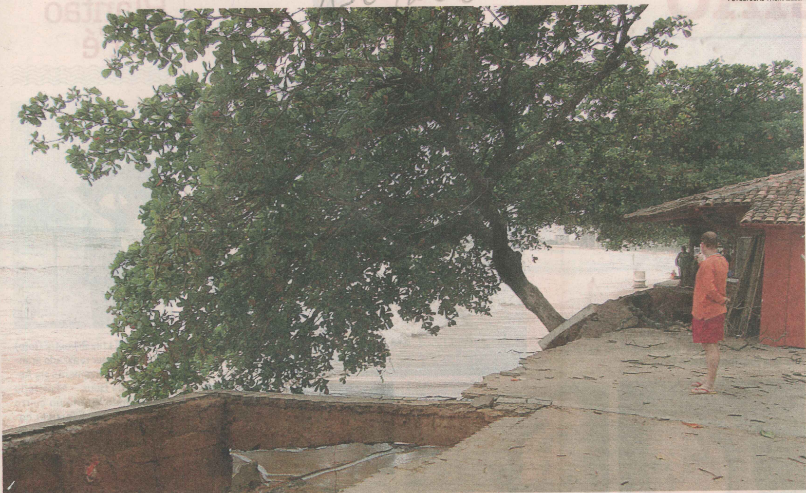
ÁRVORES CAÍRAM com a força do mar e quiosques da Praia do Morro, em Guarapari, foram isolados pela prefeitura porque apresentam riscos de desabar
