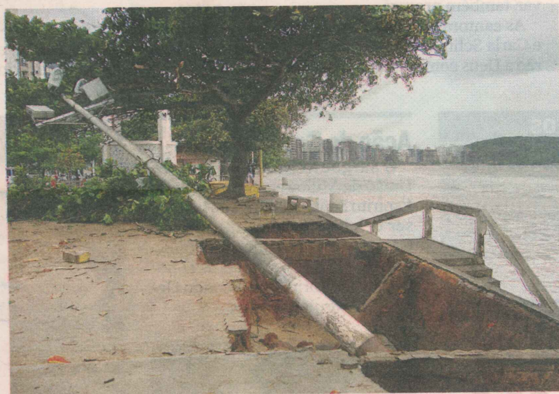
DOIS POSTES de iluminação caíram e outros quatro foram retirados
