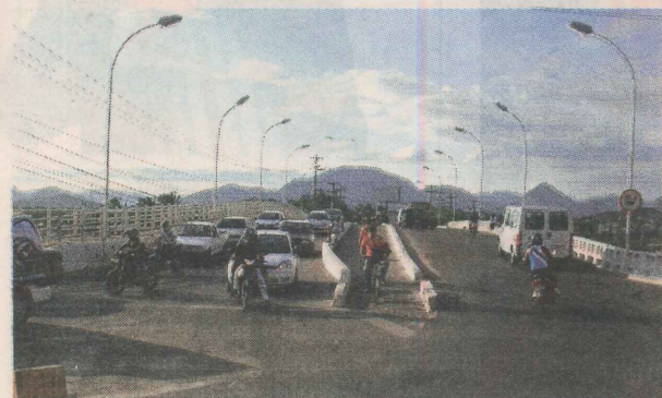
TRÁFEGO DE VEÍCULOS E MOTOS nas pontes, situadas na Rodovia do Sol. Promotoria pede multa diária de R$ 5 mil para descumprimento da proposta
