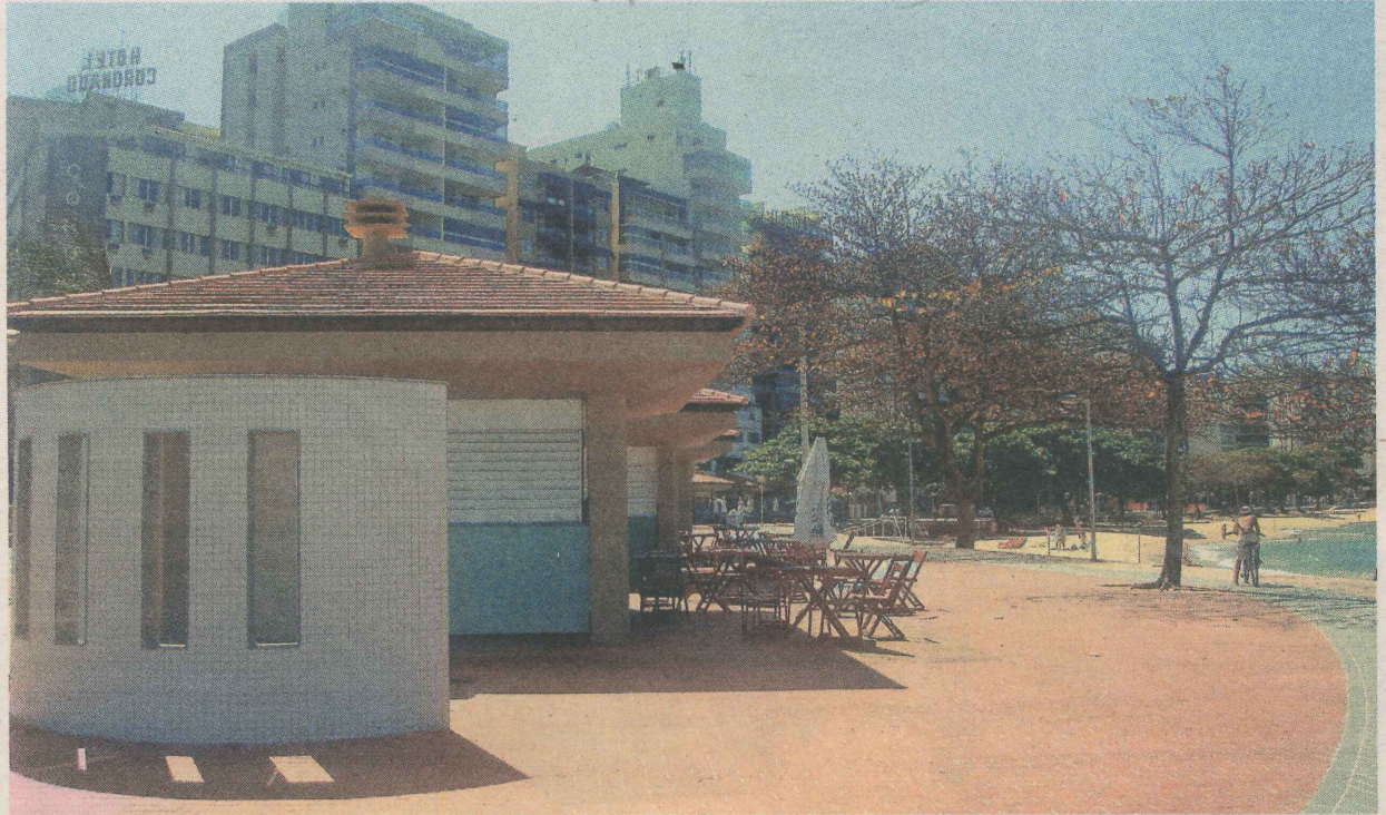
VISTA DE QUIOSQUE , com chuveiros ao lado, e o novo calçadão construído na Praia das Castanheiras
