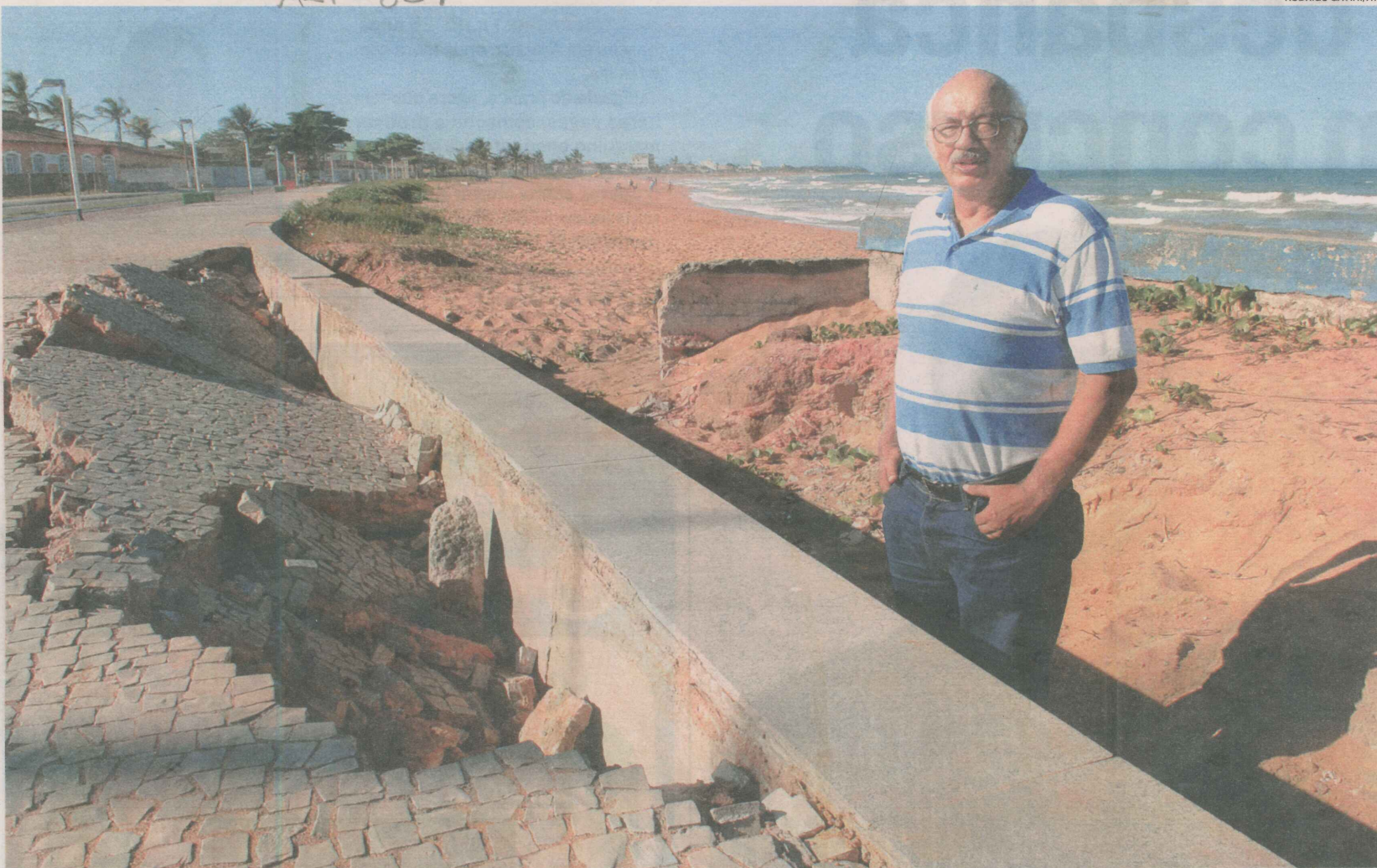
ANTONIO SÉRGIO mostra erosão na orla que, segundo ele pode ser provocada por correntes marítimas, que tiram areia de um local e depositam em outro
